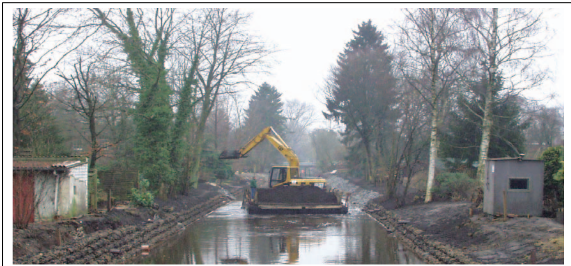
Blick von der Brücke Uhlhornsweg in Richtung Stadtmitte (Osten), während der Ausbaurbeiten
